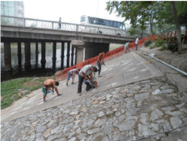
硬质边坡锚杆安装
