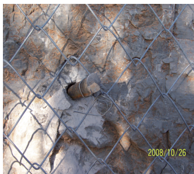
铁丝网铺设安装
